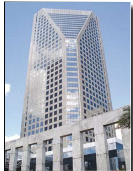
Torre Norte do CENU - Fachada
